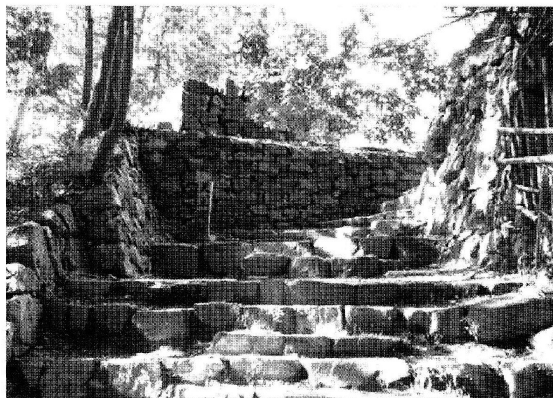
安土城本丸跡(本丸御殿から天主台に上がる石段垣)
